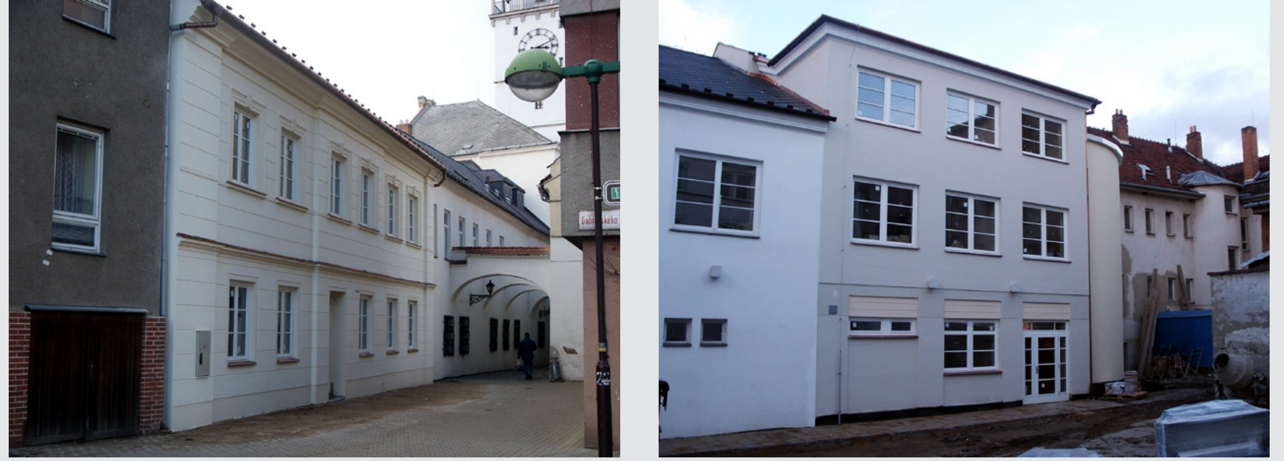
Stav po rekonstrukci
